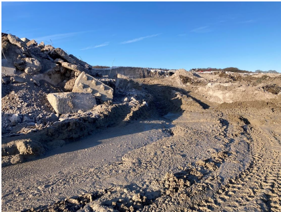
Figur 6: Foto fra den 6. januar 2024. Den lodrette grå flade (bagerst i billedet, midtfor) viser et stort brud i den oprindelige jordbund.
